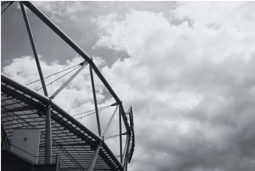
Detail vom Stadionsdach (außen)/detail of the stadium roof (outside)
